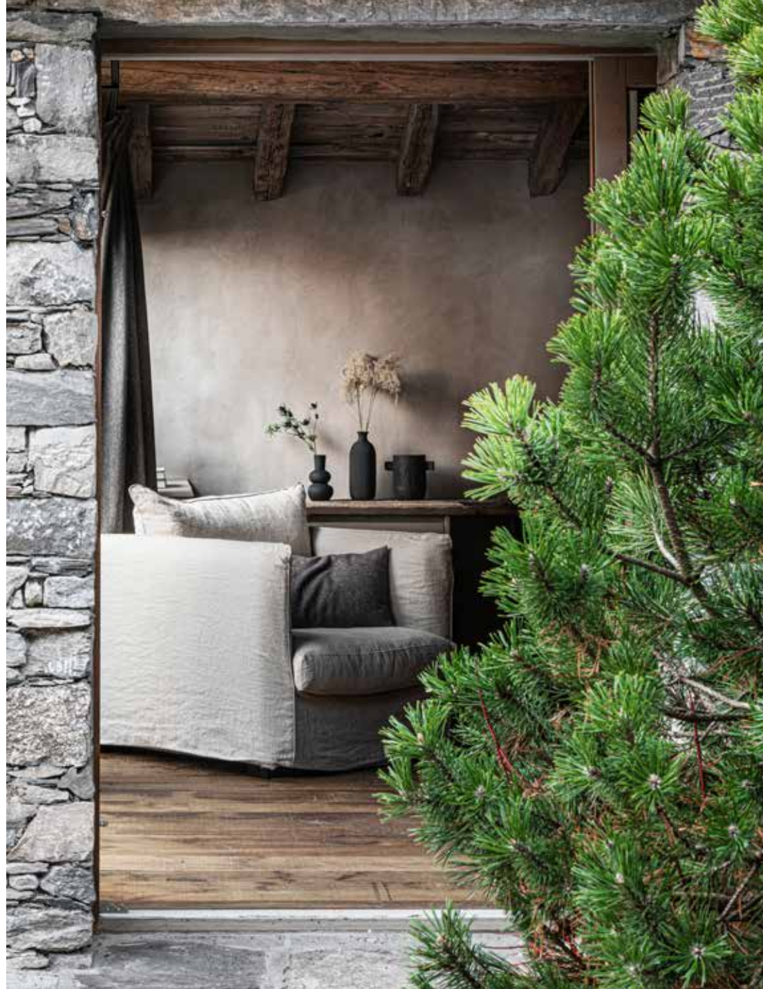
De oorspronkelijke smederij dateert uit 1768. De muren zijn gemaakt van plaatstelijke stenen, de larikshouten plafond-balken komen van de sloop van een oude schuur in het naastgelegen dorp.
