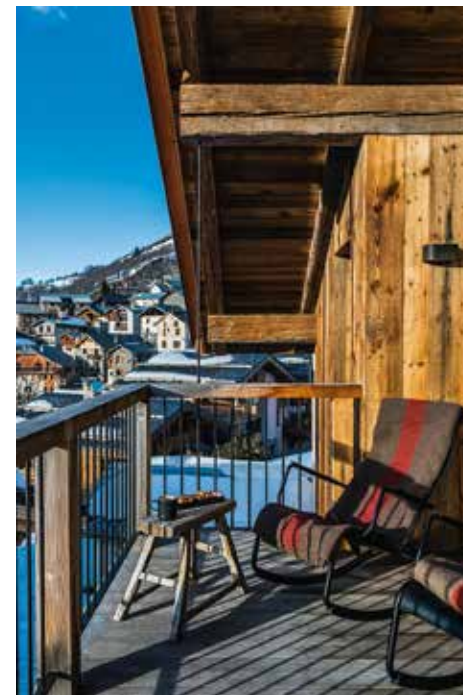
Beim Umbau wurden die originalen Balken des Gebäudes freigelegt, geprüft und wenn möglich wiederverwendet.
